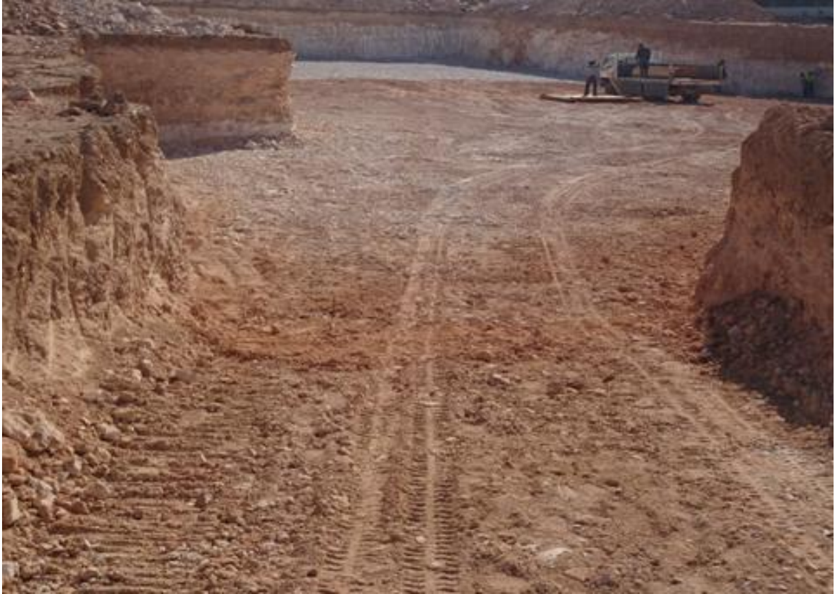
Kütüphane Binası İnşaatı
