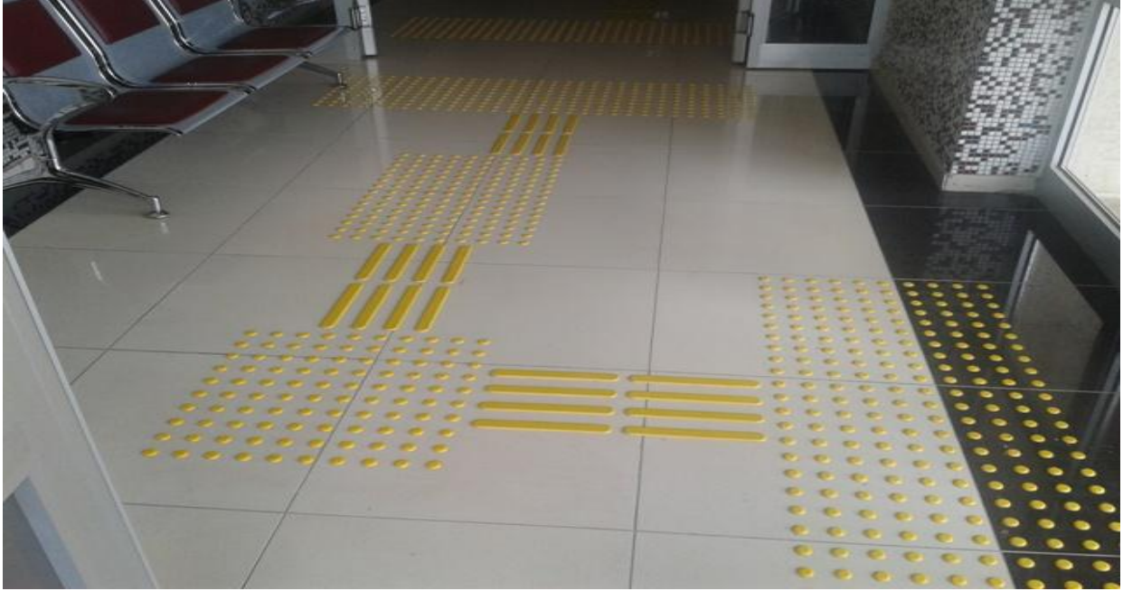
Hissedilebilir Yürüme Yüzeyleri
